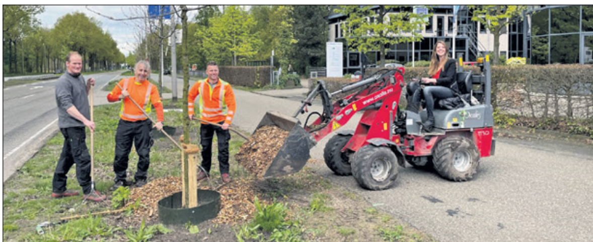
De laatste werkzaamheden worden verricht.
