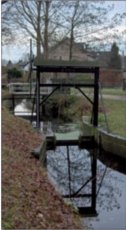
Bij een foto van een van de onlangs gerestaureerde sluisjes langs de Dorpsweg in Maartensdijk wordt les gegeven in de functie van de sluisjes, nu en vroeger.
