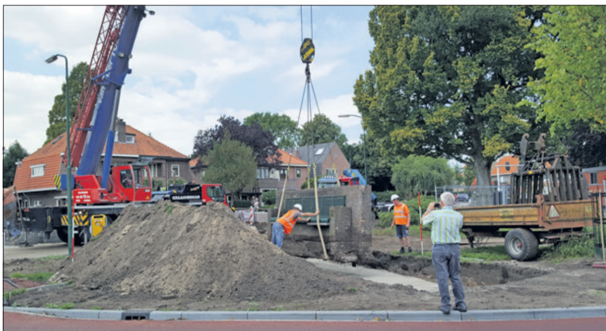
Een spectaculair onderdeel van de werkzaamheden vormde de verplaatsing van de dr. Lettebank. Op de foto filmt Jan Bulk de werkzaamheden. Zie de opname op www.vierklank.nl onder 'Reconstructie dr. Letteplein'. (foto Bert Willemse)
