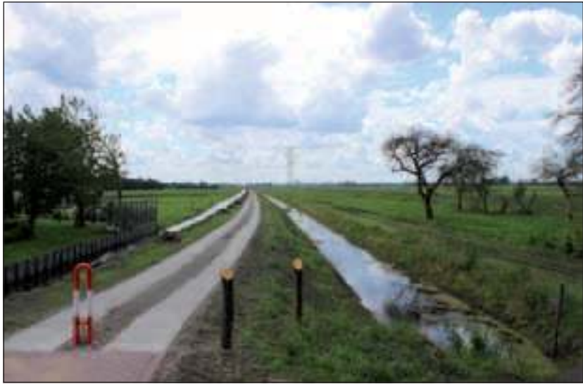
Vanaf de Achterwetering gezien, ten westen van de Nieuwe Wetering is de aanleg van een fietspad en parallel daaraan een moerasstrook op en langs de Groene Kade tot aan de Kooijdijk, richting Ruigenhoeksedijk gerealiseerd.
