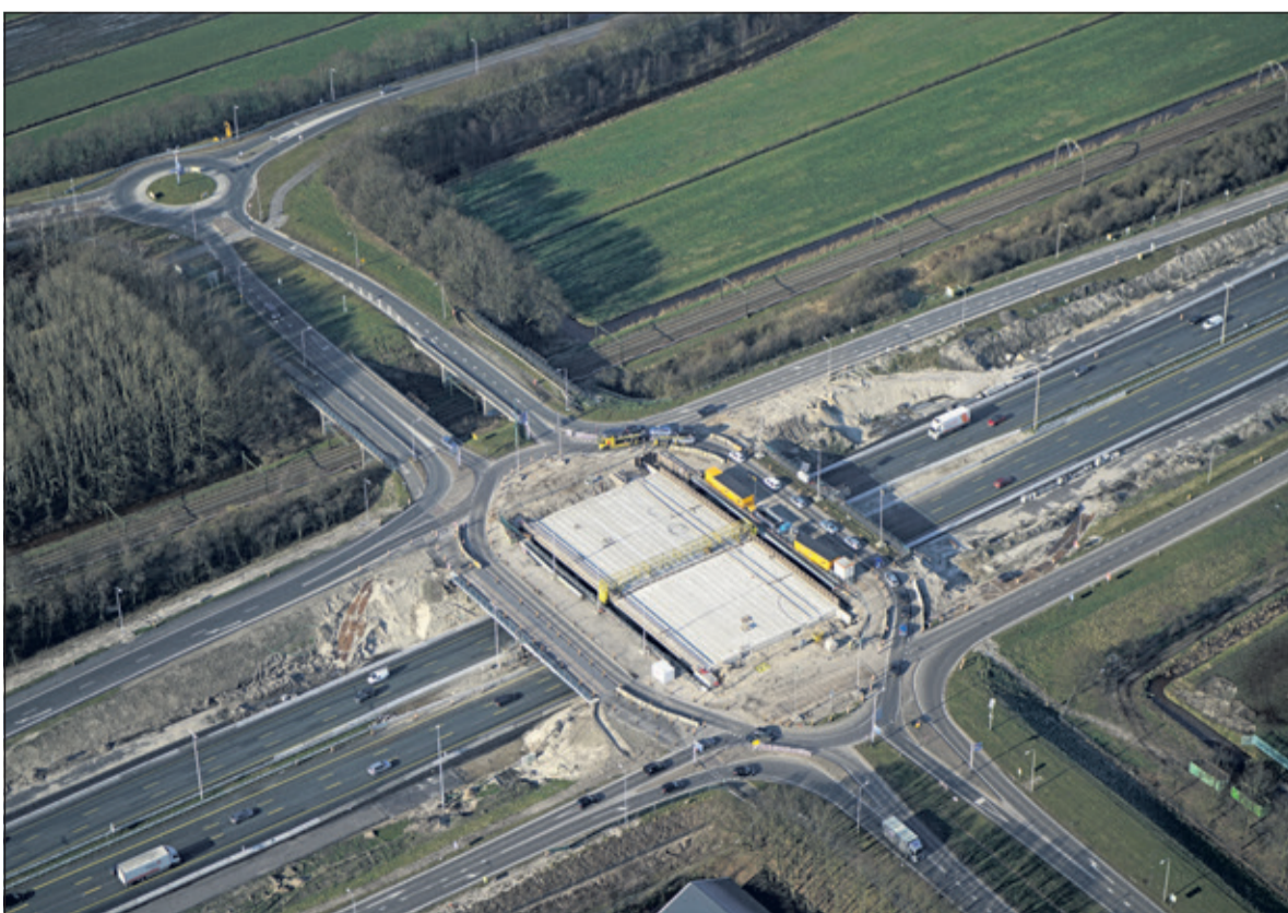
De vorderingen bij de Ovonde in Groenekan zijn vanaf de lucht goed te zien. [foto RWS]
