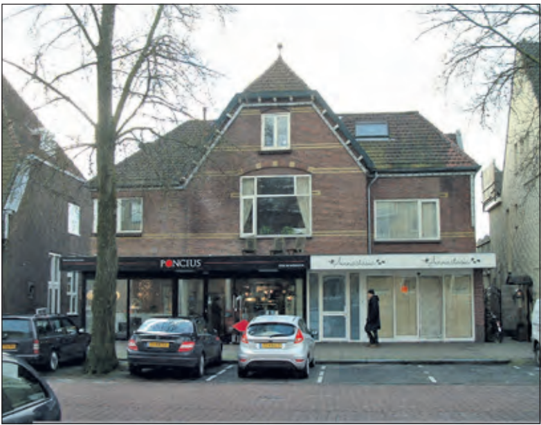
In augustus 2012 is het pand Julianalaan 8-8a ('Poncius') afgebroken als onderdeel van het nieuwe stratenplan in het dorp. Hier is een zg. 'doorsteek' gemaakt met de naam Melchiorlaan. (foto Historische Kring De Bilt)
