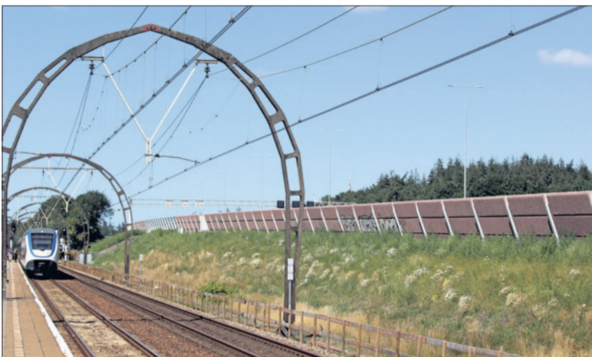
Vanaf het perron in Hollandsche Rading zijn de hoge lichtmasten (in het midden van de A27) die ruim boven het geluidsscherm, de trein en de unieke spoorbogen uitsteken, goed te zien.
