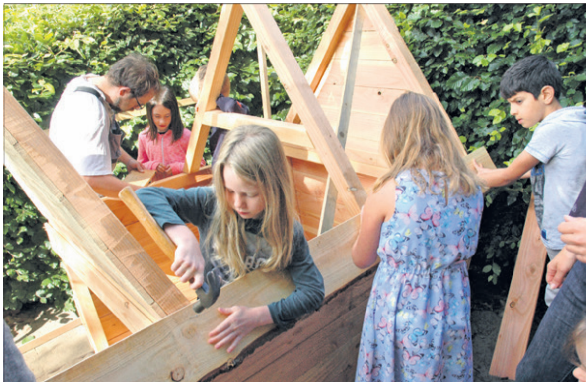
Groep 5 is geconcentreerd bezig met de bouw van een speelhuisje.
