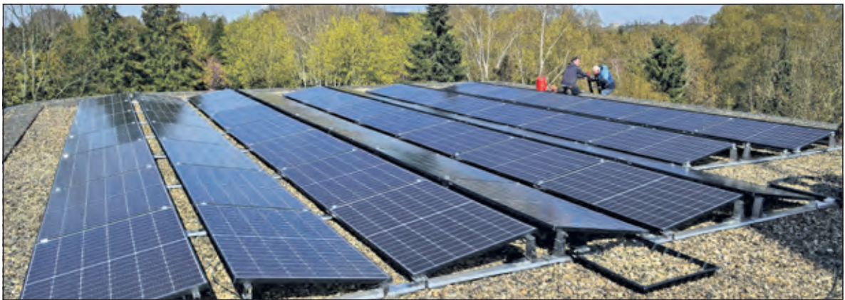
Op het dak van de Oosterlichtkerk zijn 80 zonnepanelen geplaatst. (foto Nico van den Ham)
