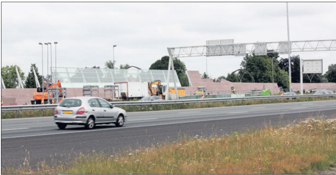
Schermen verzorgingsplaats Nijpoort in opbouw.
