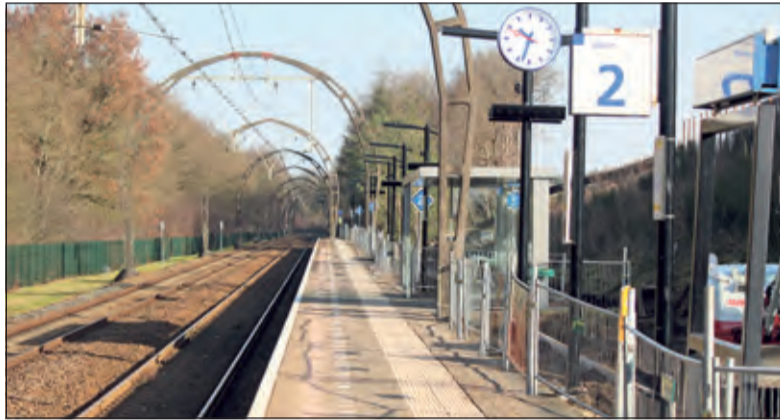
De spoorlijn Hilversum-Utrecht staat bekend om een bijzonder type 'monumentale' bovenleidingportalen, die als bijnaam de Gotische Bogen hebben.
