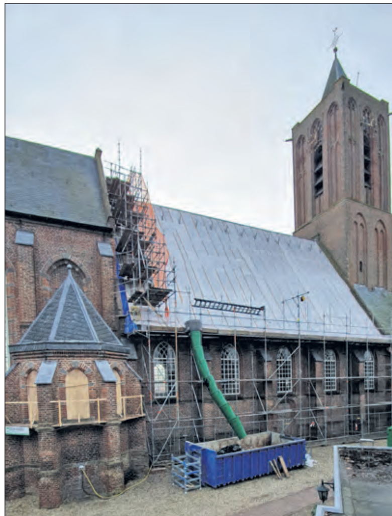
De restauratie van het dak is eind september begonnen en wordt naar verwachting in februari afgerond.
