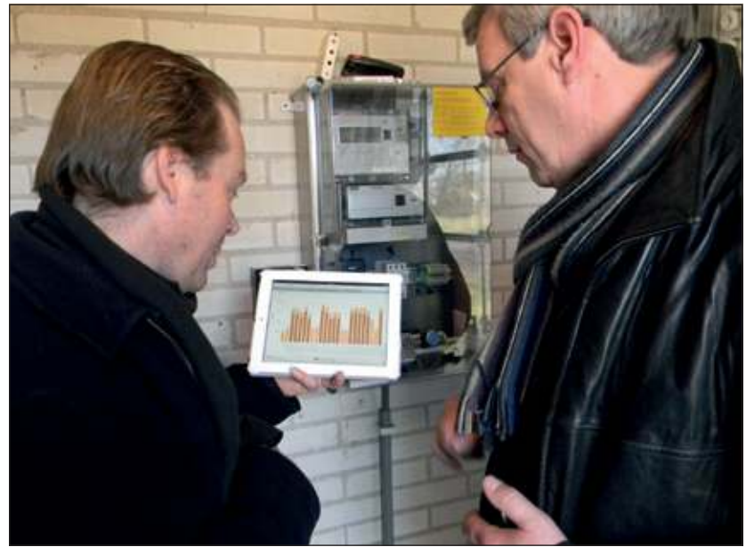
Ron de Bruijn (Pura Vida Renewable Energy BV) en Chiel van Broekhuizen bij de slimme meter in de meterkast van het gemeentehuis.
