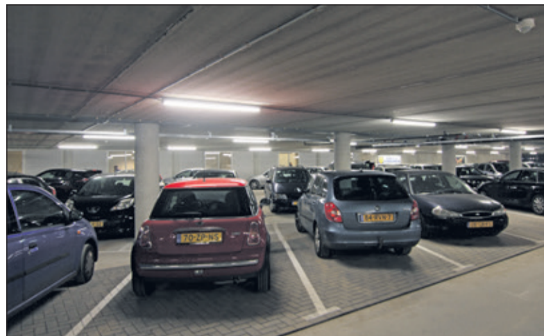
Het nieuwe gedeelte van de parkeergarage onder de Kwinkelier wordt goed gebruikt.
