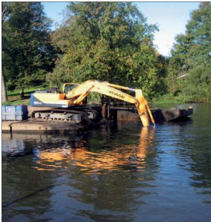
De kraan baggert de modder uit het steeds dieper wordend gat.
