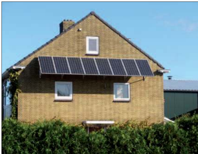
Vindingrijke plaatsing van zonnepanelen in Groenekan
