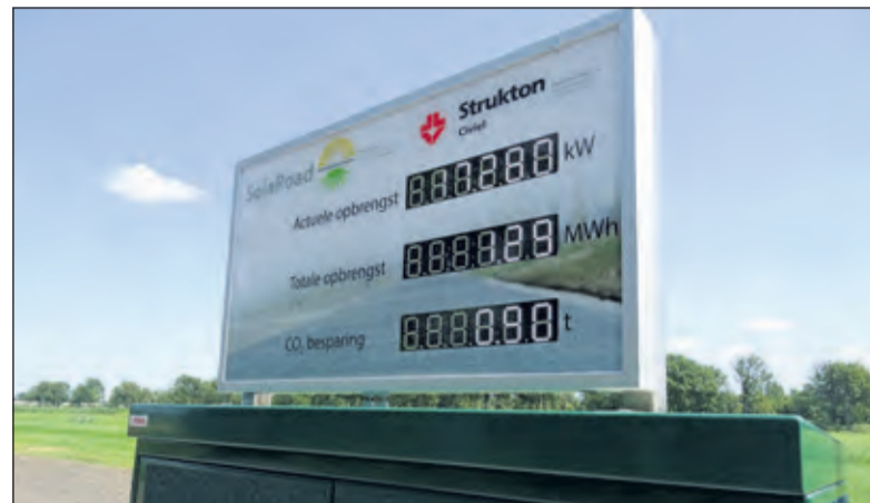
Op de meterkast is af te lezen hoeveel energie er is opgewekt en aan het netwerk wordt afgegeven.
