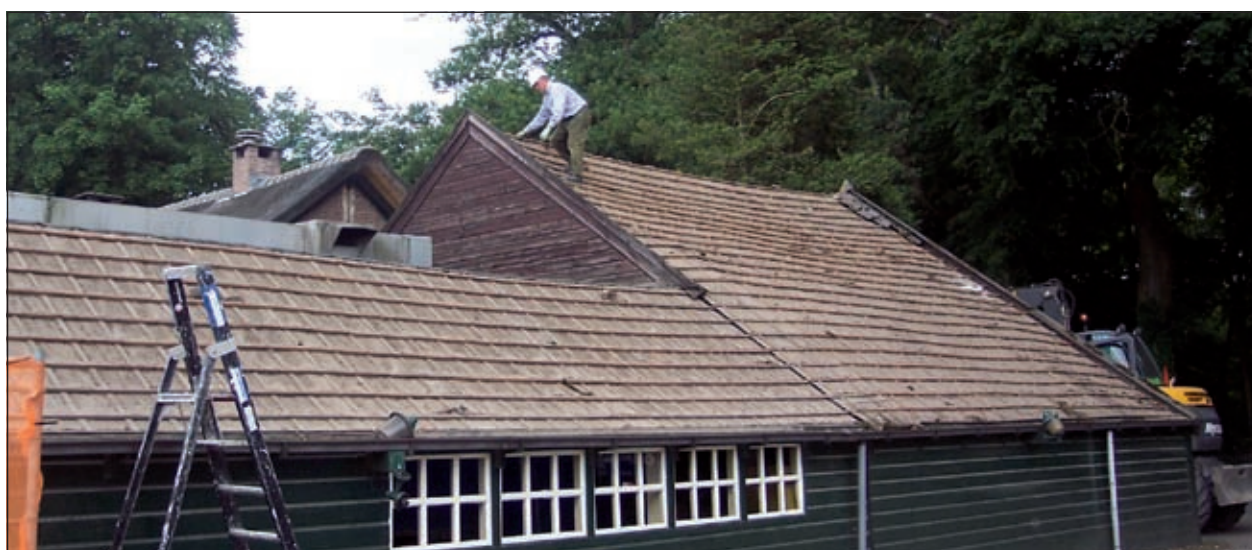
Vorige week maandag is men begonnen met de sloop van het achterhuis van De Mauritshoeve. Medewerkers van aannemer Veldhuizen uit Westbroek halen de pannen van het dak.
