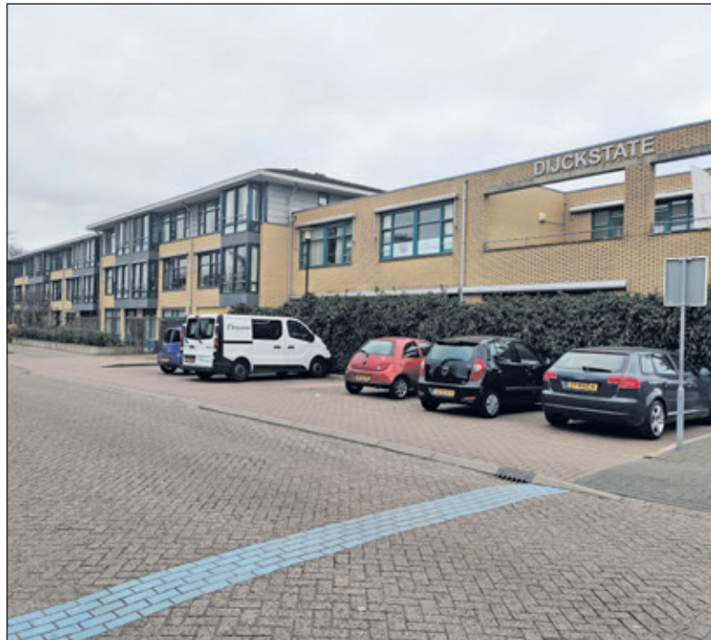
De gemeenschapsvoorziening is uit Dijckstate verdwenen, het restaurant gesloten en de huisartsen, de apotheek en Stichting Mens huren nu ruimten in Dijckstate. De naam 'Dijckstate' staat vermeld op het verhuurde deel.
