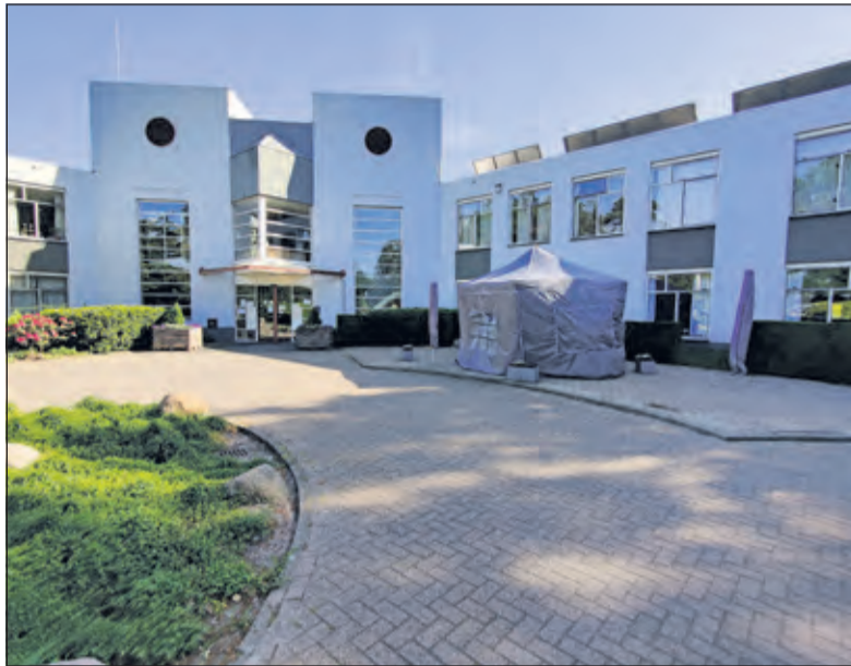
De tent is inmiddels buiten bij De Biltse Hof geplaatst.
