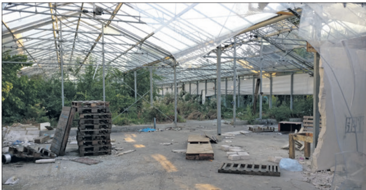
Het onkruid en de bomen groeien bijna door het dak en alle zijramen zijn inmiddels door vandalisme vernield.
