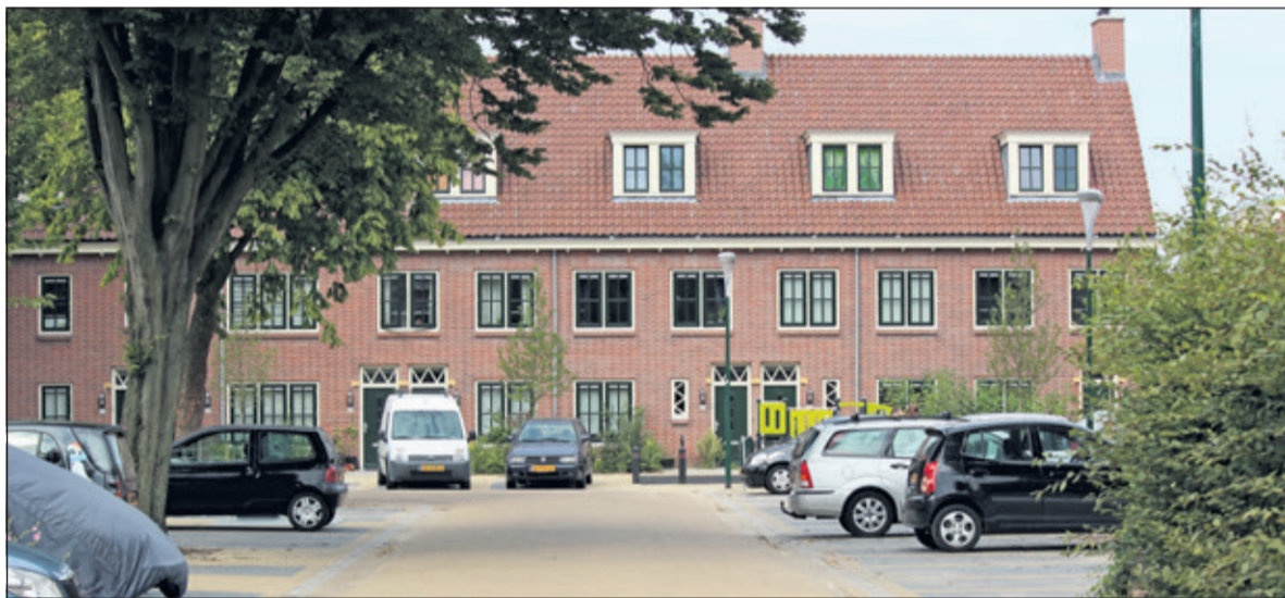
De twee locaties ter hoogte van de huisnummers 87 en 255 worden nog omgebouwd naar uitsluitend PMD.
