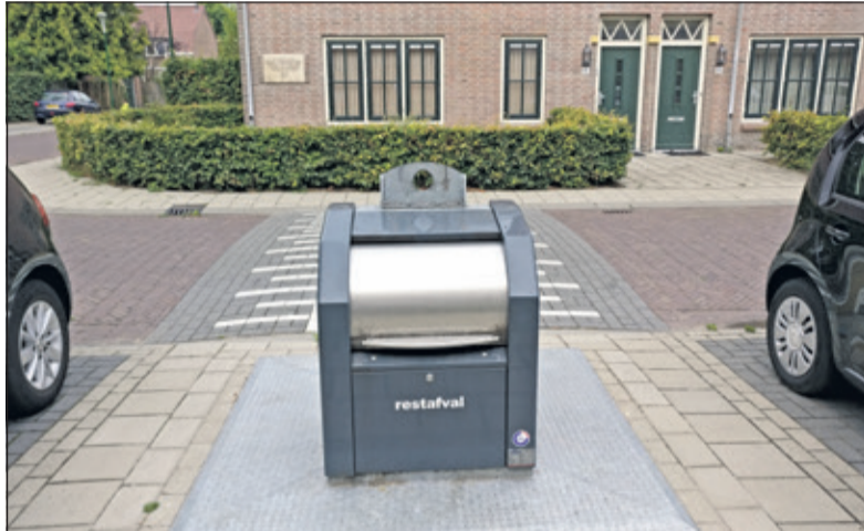
De twee locaties ter hoogte van de huisnummers 87 en 255 worden nog omgebouwd naar uitsluitend PMD.
