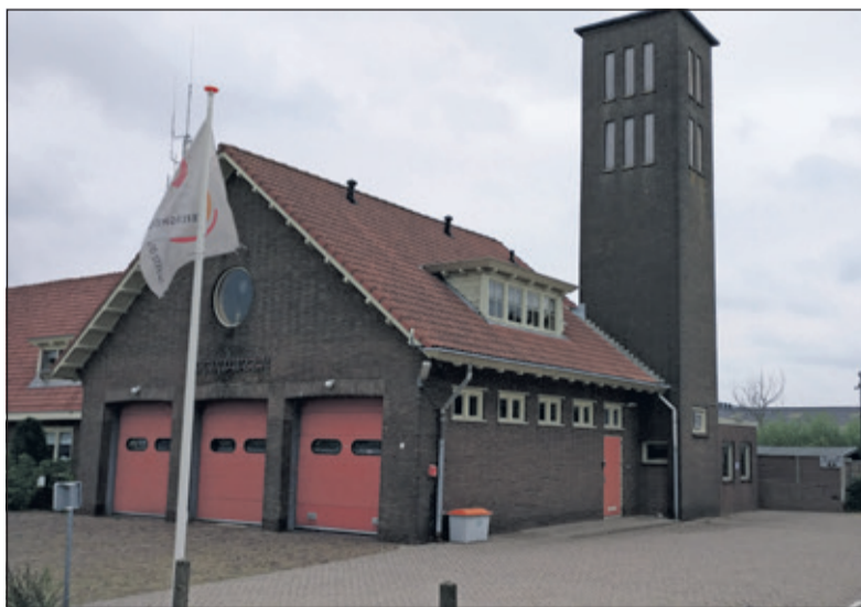
Door de landelijke ligging is de toren van de brandweerkazerne Maartensdijk één van de herkenningspunten binnen de gemeente. [foto Henk van de Bunt]
