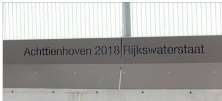
Het Maartensdijkse Viaduct heet Achtthhoven.
