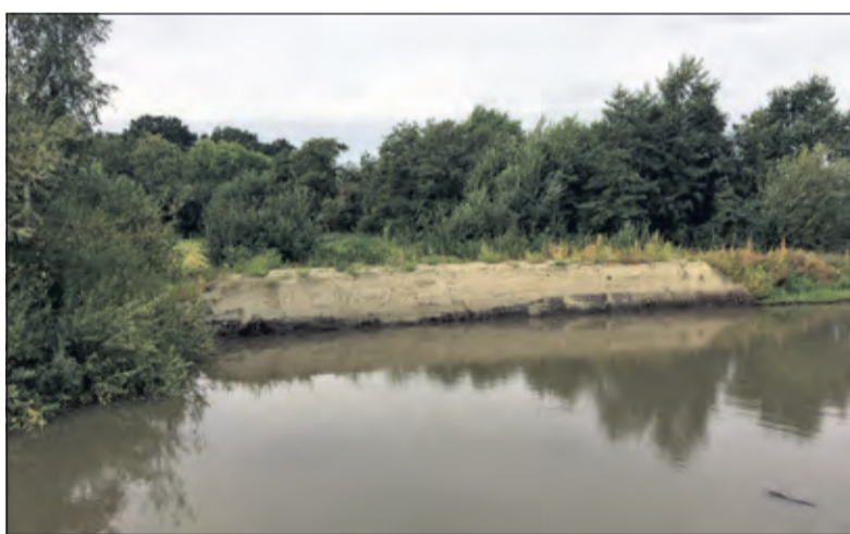
Langs de zuidoever (zijde Fort Voordorp) is een oeverzwaluwwand aangelegd. (foto Wim Vermeule)
