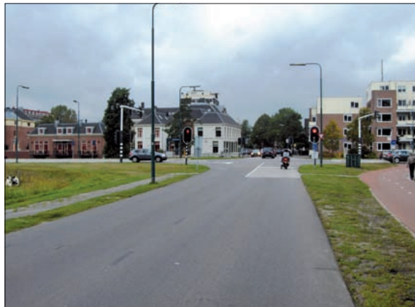
Het kruispunt Soestdijkseweg Zuid-Dorpsstraat/De Holle Bilt is uitgerust met een verkeersregelinstantie (VRI). Op basis van 'praktische' problemen moet onderzocht worden of een tunnel dichterbij de N237 kan komen te liggen.
