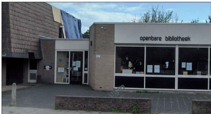
Er is brand geweest in de bibliotheek en dansschool aan de Alfred Nobellaan, waardoor de Biltse vestiging rook- en waterschade heeft opgelopen. De gehele collectie is daardoor helaas verloren gegaan.
