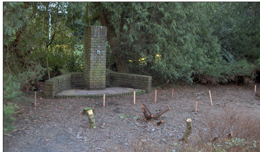
In februari is te zien dat een deel van de werkzaamheden gerealiseerd is. Ook het oude afgetapte watertappunt is zichtbaar.
