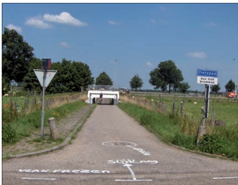
Ook het Oostveensepad wordt tijdens de asfaltwerkzaamheden in zijn geheel afgesloten. Met grote witte letters staan de werkopdrachten aangegeven. [HvdB].
