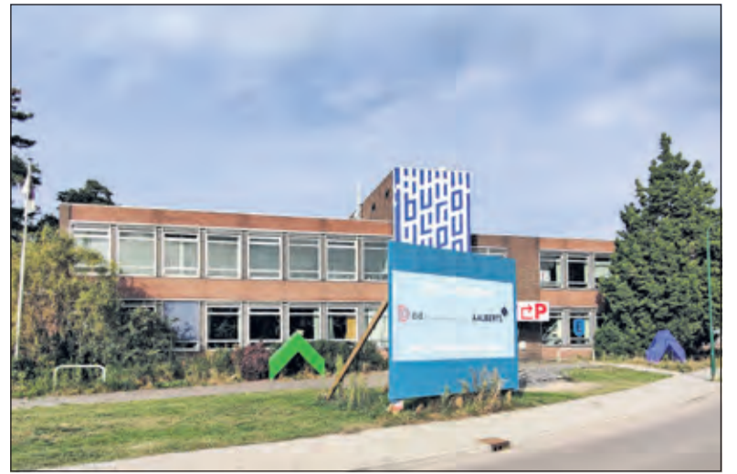
Aalberts & Did BV willen op het terrein van het leegstaande politiebureau woningen realiseren.
