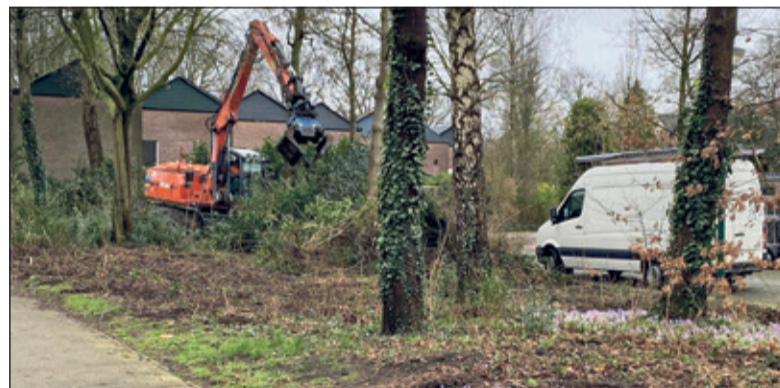
Het betreffende perk langs het fietspark bij de supermarkt wordt gesloopt.
