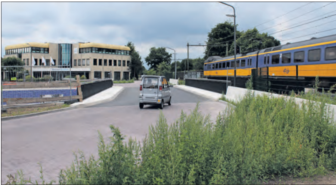
Eind april was de nieuwe weg aan de zuidzijde - vanaf de rotonde, over het verkeersdek en langs het spoor - al gereed.
