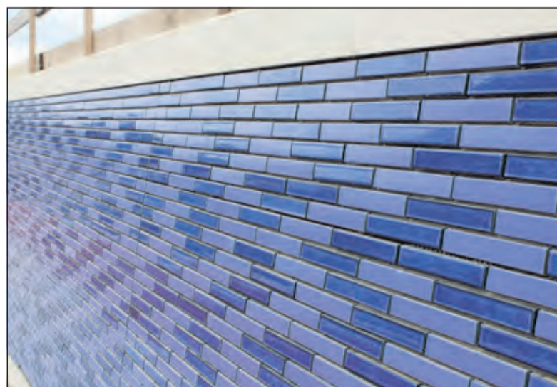
De wanden van de onderdoorgang zijn van 90.000 tegels voorzien; in het afgelopen weekeinde moest de zuidzijde nog worden gevoegd.
