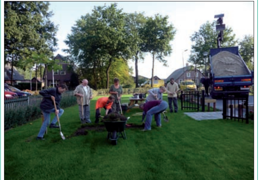
Gras en aarde werden verwijderd en daarvoor in de plaats...
