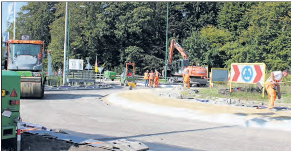
Zondagmiddag was er nog volop werk aan de rotonde met de Achterweteringseweg.
