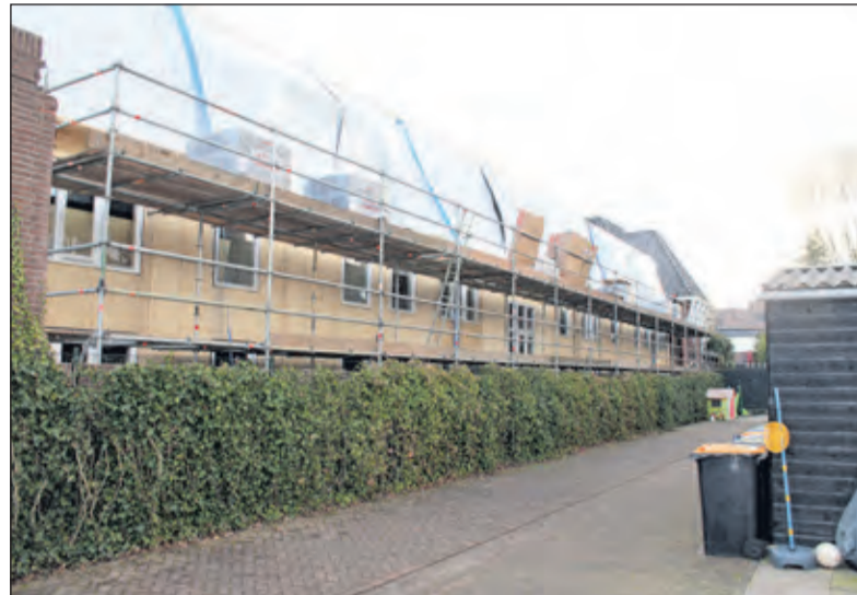
Toekomstige bewoners van de in aanbouw zijnde appartementen hebben onbeperkt zicht in de achtertuinen van de huizen aan de Hessenweg.
