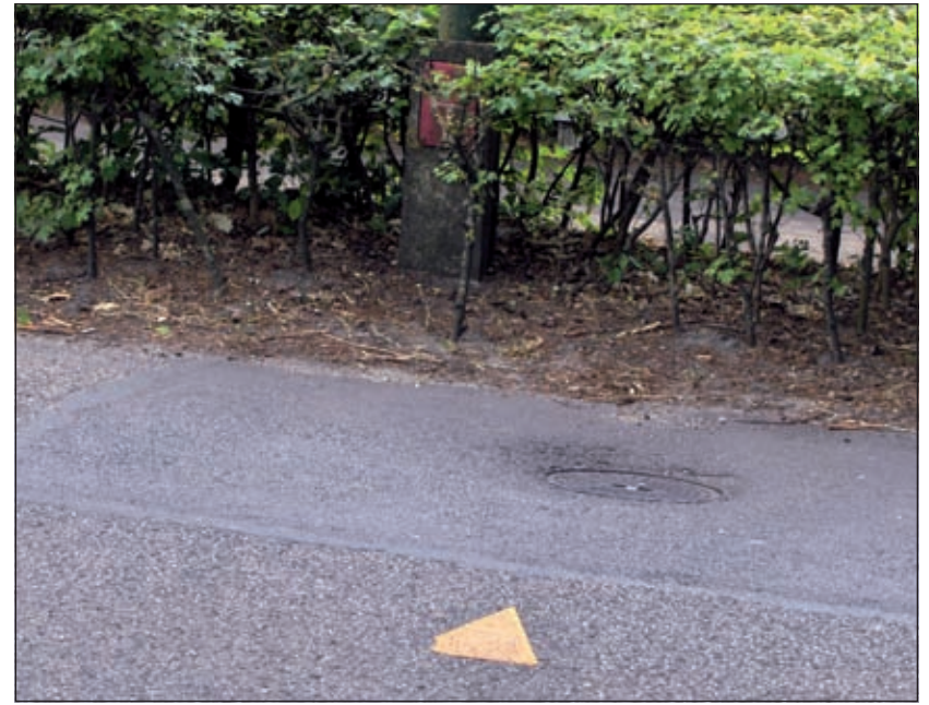
De driehoekjes op het wegdek wijzen met de punt naar de bluswatervoorziening. Soms zijn de aanduidingsbordjes overwoekerd door planten of gras.
