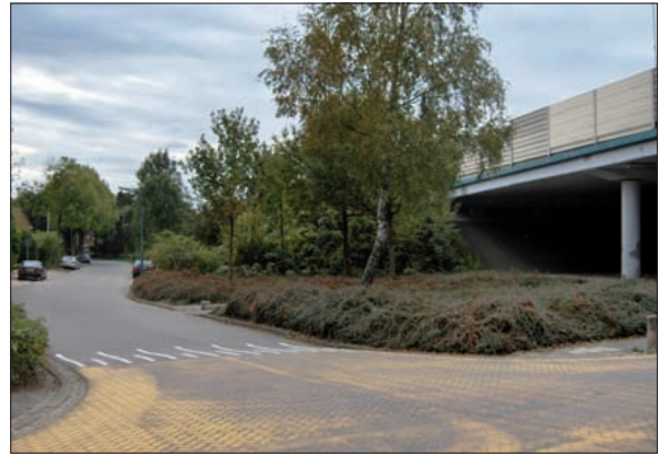
Langs de A27 is ter hoogte van Hollandse Rading een 400 meter lang scherm en een 700 meter lange 'groene' wand aangebracht.
