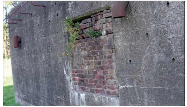
Bovenop de bunker vinden we nog steeds de haken waaraan de camouflagenetten werden vastgemaakt. Ook deze bunker bij fort Ruigenhoek is dichtgemetseld om te voorkomen dat de jeugd er in komt.
