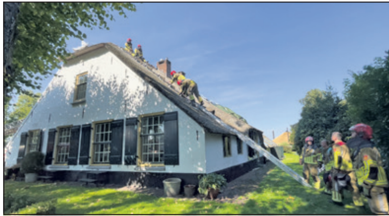
Het dak wordt grondig geïnspecteerd door de brandweer. (foto Jan Gerrit van Wijhe)
