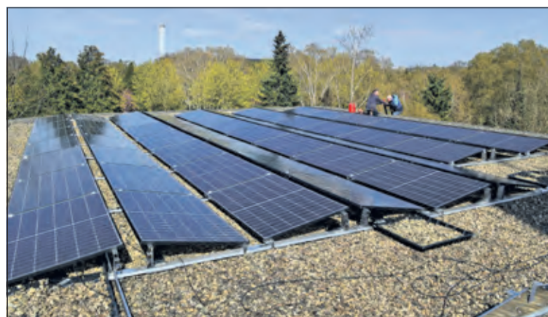
Op het dak van de Oosterlichtkerk zijn vorig jaar 80 zonnepanelen geplaatst. (foto Nico van den Ham)
