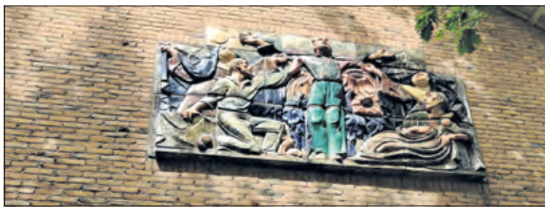
Op de voorgevel van het voormalige economiegebouw bevindt zich een hoog reliëf van geglazuurde tegels van de beeldhouwer Charles Vos.
