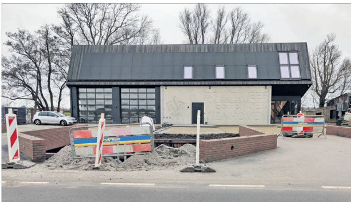
De nieuwe brandweerpost is in december 2023 opgeleverd. De officiële opening staat gepland op 9 maart 2024.
