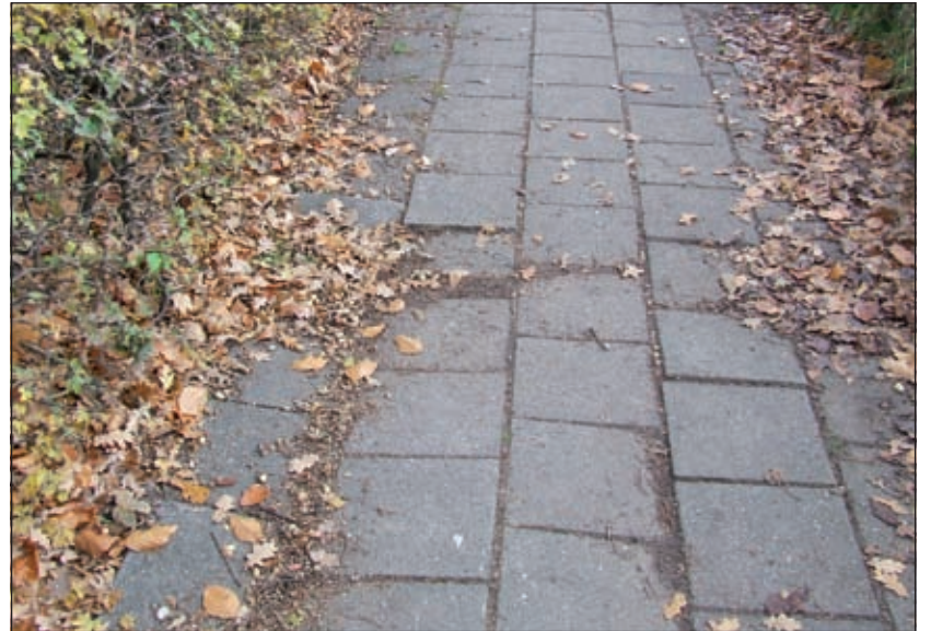
De slechte staat van het voetpad langs de Maartensdijkse Dorpsweg noopt mensen met een rollator gebruik te maken van de rijweg.
