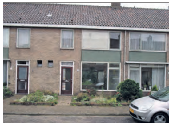
Waalseweg 10 voor de renovatie.
