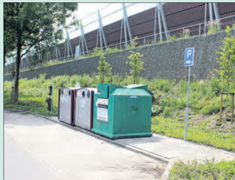
Containers in de Spoorlaan blijven bovengronds.
