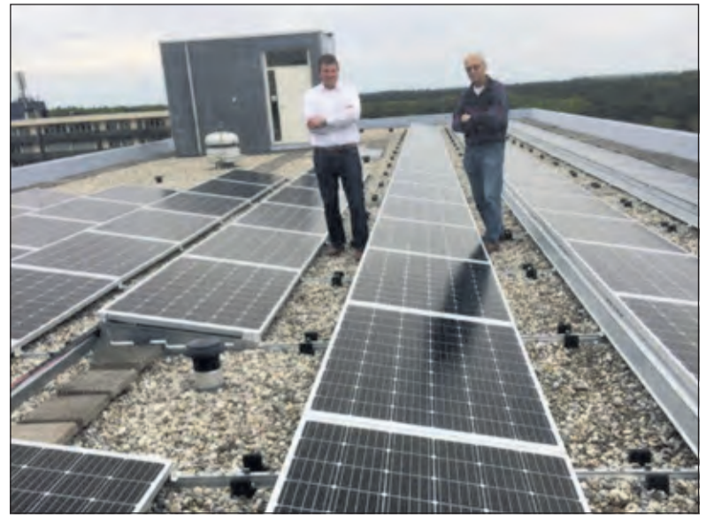
Op het dak van het flatgebouw met zonnepanelen aan de Kruisbeklaan. Links Patrick Baas en rechts Jan van Hoeijen.
