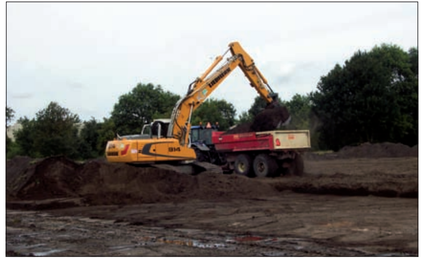
0 kubieke meter grond wordt afgegraven en vervoerd.
