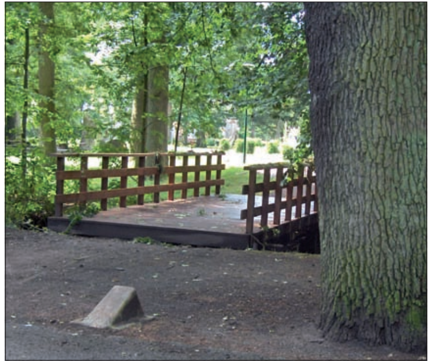
De brug in de bocht van de Grothelaan ter ontsluiting van de parkeerplaats van de Groene Daan is aangelegd zonder het wortelstelsel van de meer dan 80 jaar oude eik aan te tasten.
