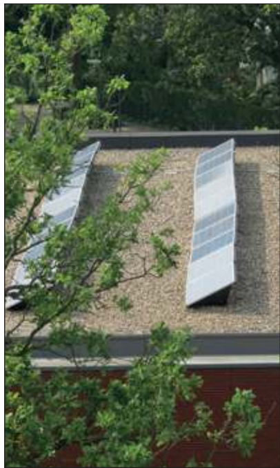
Duurzame energie op het dak van de Julianaschool in Bilthoven.
