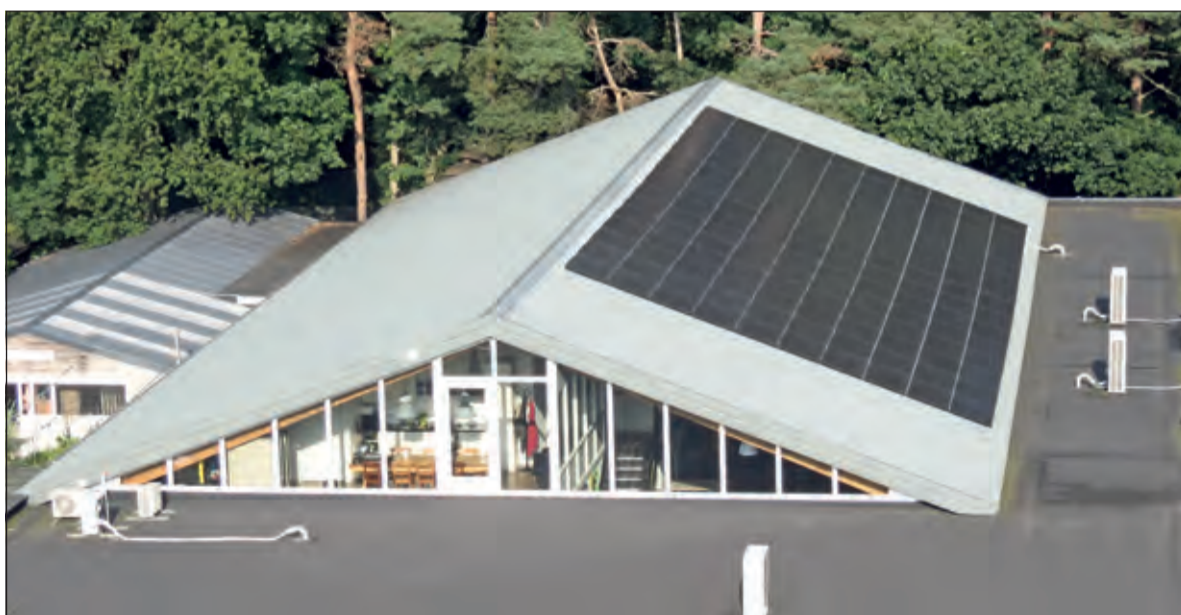
Zonnepanelen op het dak leveren een flinke besparing op.
