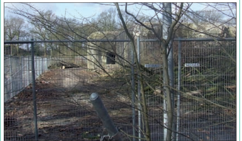
Bilts Belang pleit voor hergebruik van de bunker.
