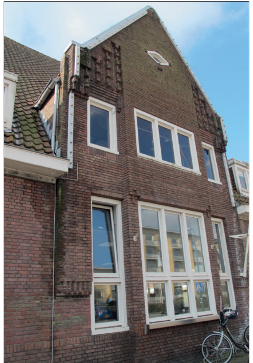
Het voormalige postkantoor van Bilthoven ligt er verlaten bij. De ombouw tot grand café kan pas plaatsvinden als de gemeente en Stranders een oplossing hebben gevonden voor het asbestbesmettingsprobleem.
