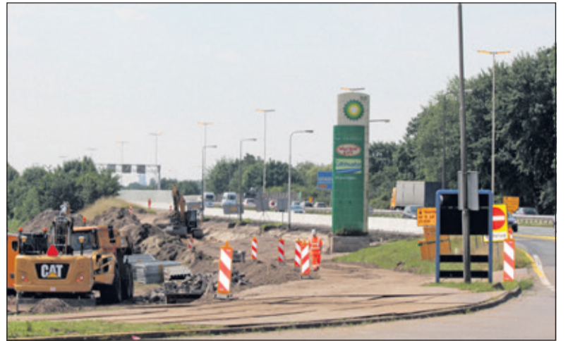
Aan de oostzijde van de A27 wordt achter de schermen voorbereidend werk verricht.
