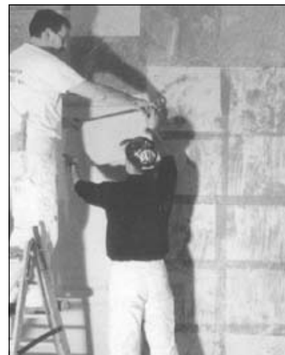
Behangers bezig met het betengelen van een wand (Foto uit 'Linnen, restauratie, spannen, schildertechnieken' door Jan Heesters).
