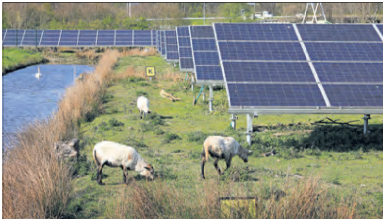
Energie opwekken en zorgen dat het aangesloten wordt op het elektriciteitsnet is een opgave.
