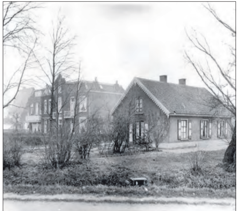
De eind jaren 60 afgebroken boerderij met linksachter de huizen aan de Steinenburgerlaan.
