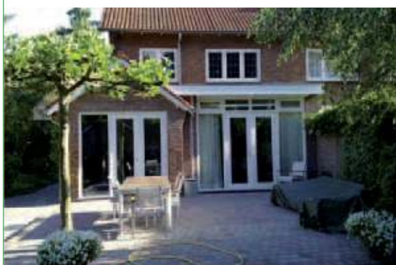
Renovatie en uitbouw
