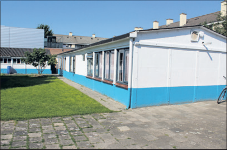
De voormalige bebouwing (o.a. moskee) is gesloopt.
