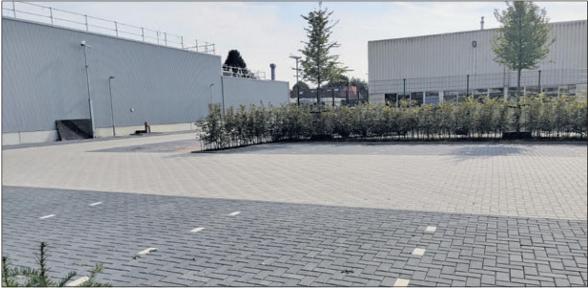
De aangelegde parkeerplaats draagt bij aan het oplossen van de parkeerproblematiek in de Ambachtstraat.
